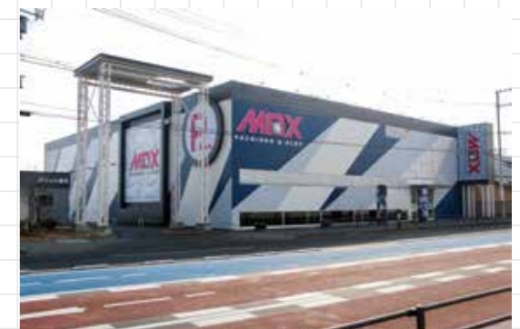
店舗外観。裏手には700台を収容できる駐車場が広がる
